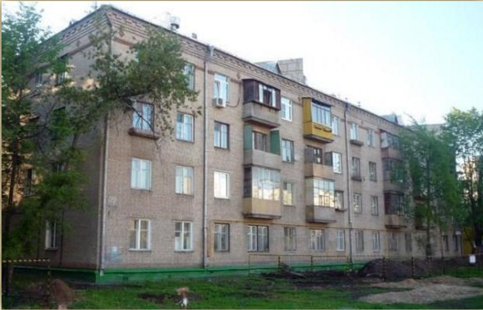
Дом на Ярославском шоссе, в котором жили прабабушка Мария и прадедушка Владимир, строил прадедушка
