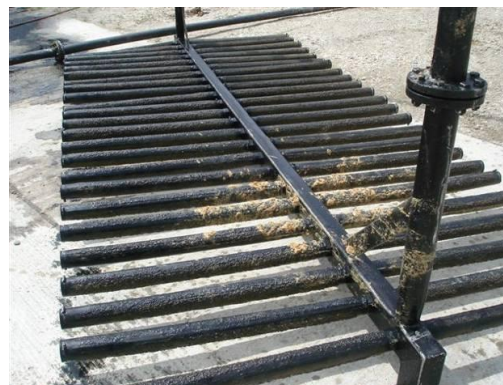
Мелкопузырчатая аэрация в аэротенке: слева – этап строительства; справа – аэраторы, поднятые из аэротенка для осмотра
