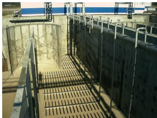
Мелкопузырчатая аэрация в аэротенке: слева – этап строительства; справа – аэраторы, поднятые из аэротенка для осмотра
