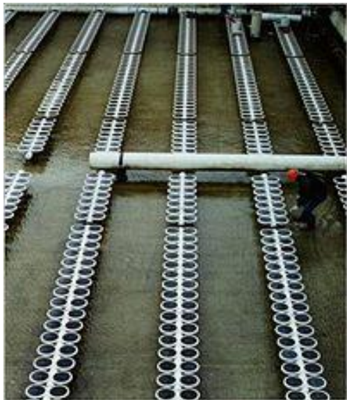
Аэрация мембранными диффузорами в аэротенке
