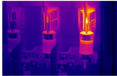
Рис 7. Температурная шкала выбрана так, чтобы увидеть предохранитель.
