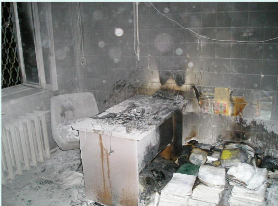
Помещение со следами возгорания в следствие перегрузки
