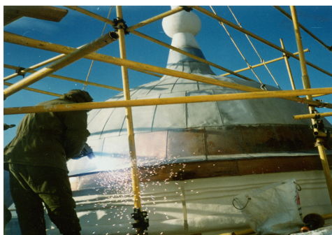
Металлизация алюминией с последующим шлифованием куполов храма
