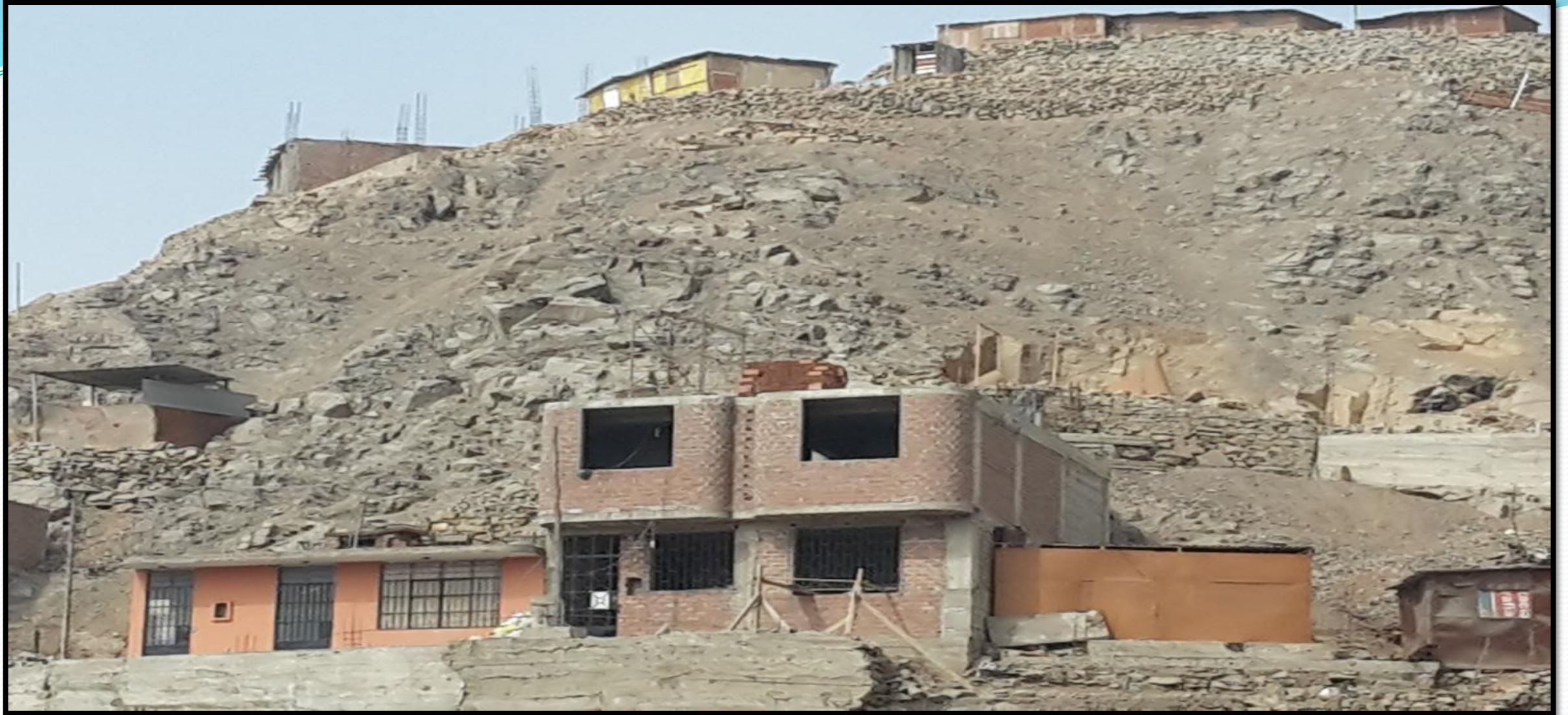
Peligro Físico, construcción informal en las laderas y parte superior del cerro, sin ninguna cimentación.
