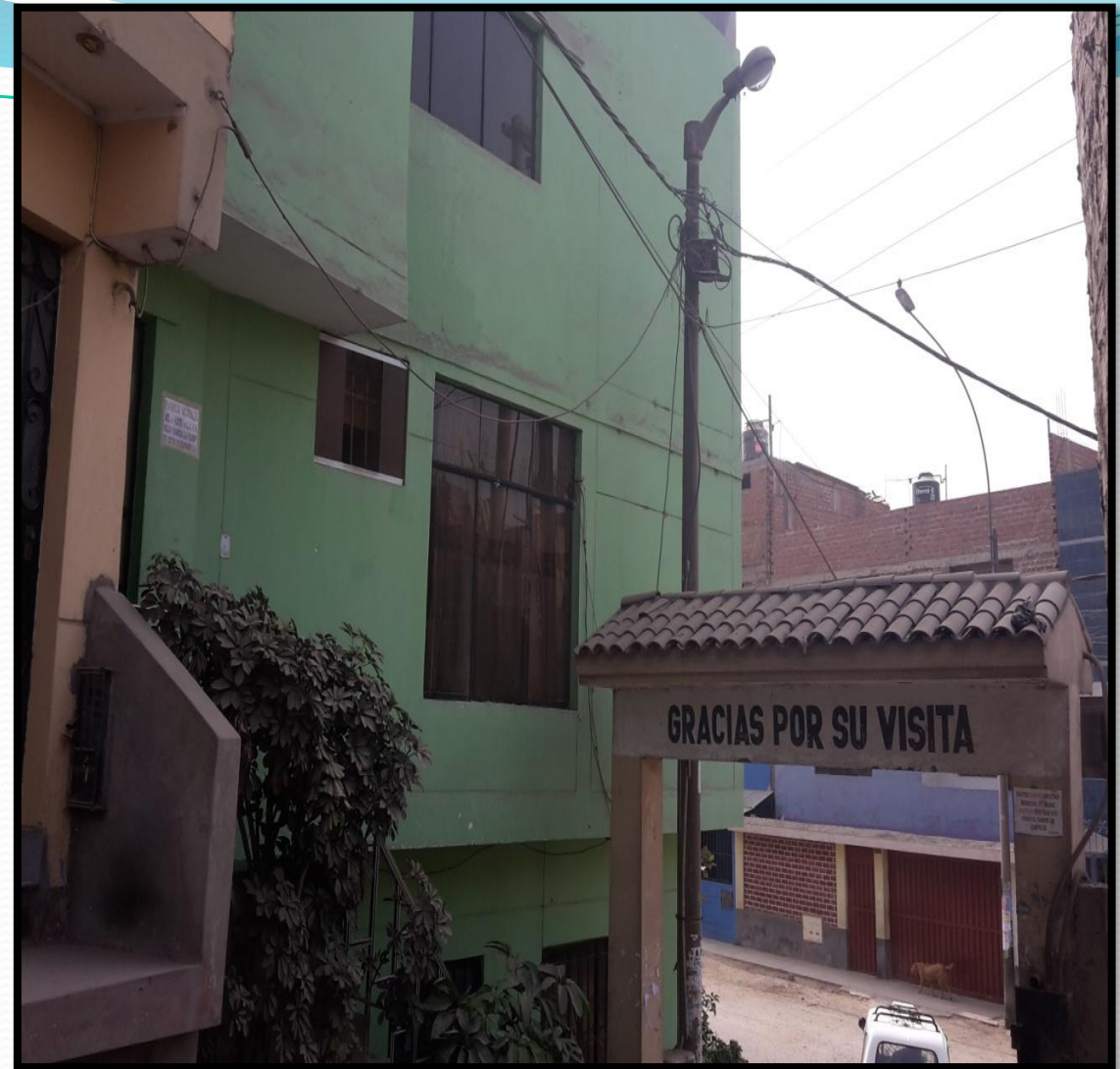
Imagen 20. Vivienda construida muy próxima a un poste de alumbrado público, además presenta invasión de las veredas con sus escaleras de acceso.
