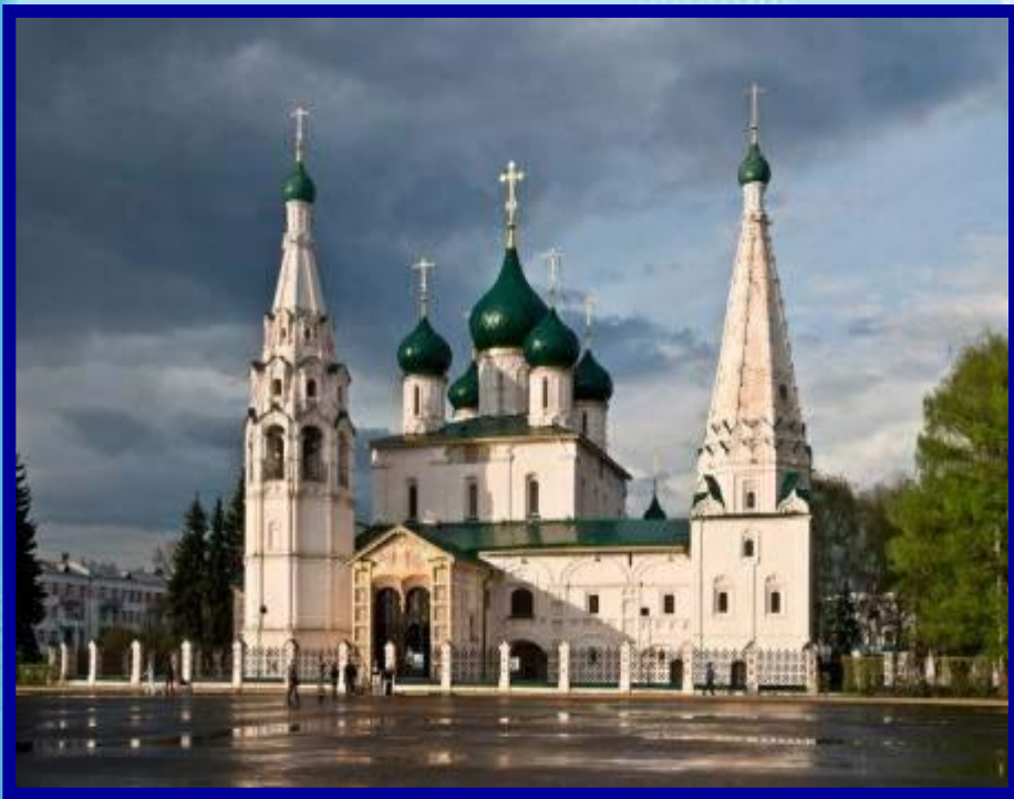
Церковь Ильи Пророка в Ярославле.
