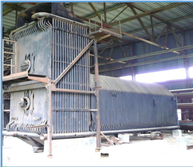
Ремонт резервного оборудования котельной №328Р (замена котла КГВМ 20-150)
