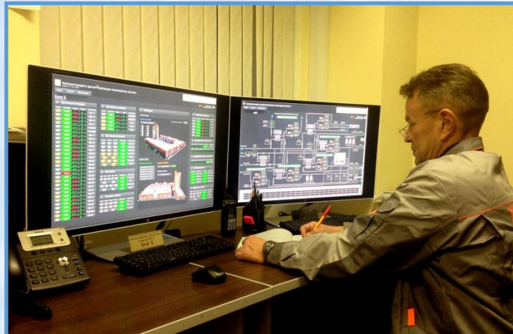
Автоматизация и диспетчеризация теплового хозяйства военного городка
