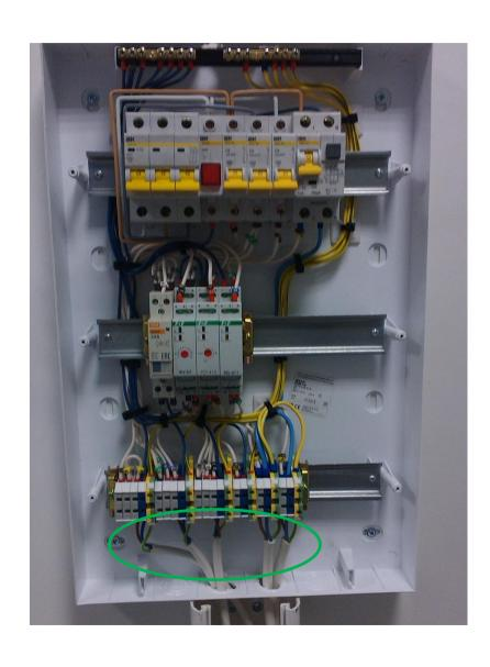
F2. Провода и кабели заходят в ЩУ в двойной изоляции.
