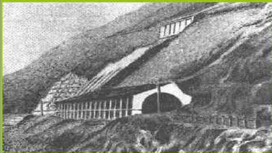
Галерея для защиты дороги от осыпи, начало 1900-х (Ананьев, Потапов, 2000)
