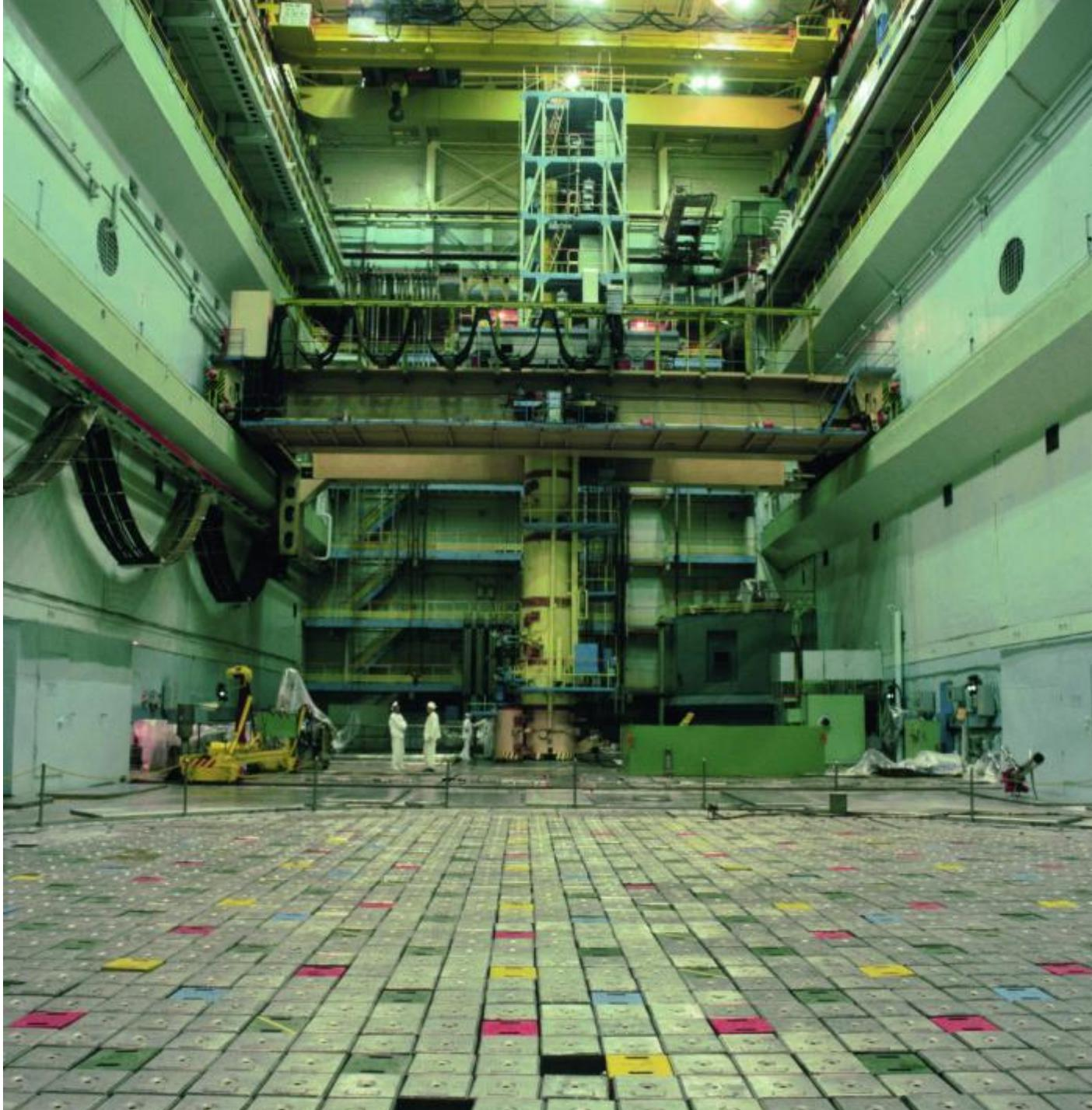
МК схемы "Г" представляет собой **плиты и короба** перекрытий и предназначена **для биологической защиты** центрального зала **от ионизирующего излучения коммуникаций верха реактора.**
