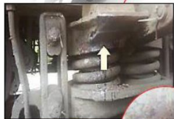
Коррозийный износ усиливающего наклонного листа наддрессорной балки в месте крепления продольного поводка
