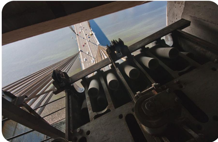
Рис.22.13. Крепление вант внутри пилона
