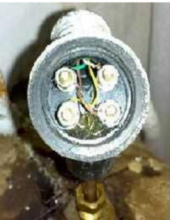
Двухпроводная схема
