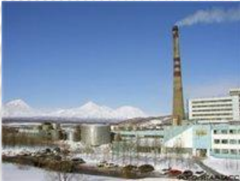
Паужетская геотермальная станция
