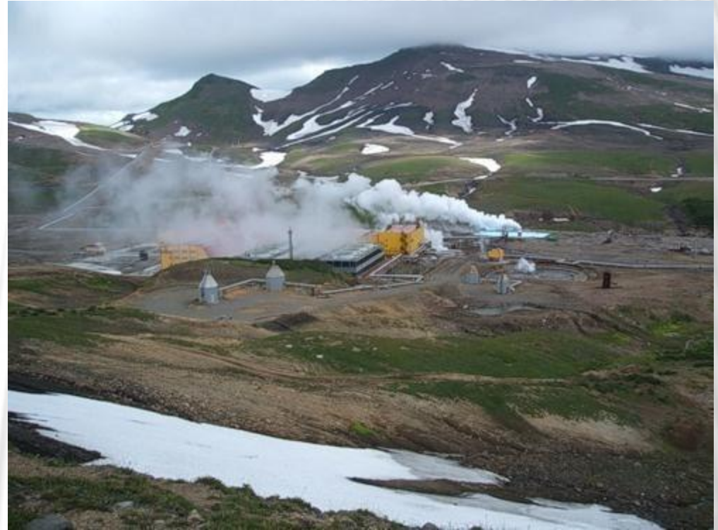
Мутновская геотермальная станция
