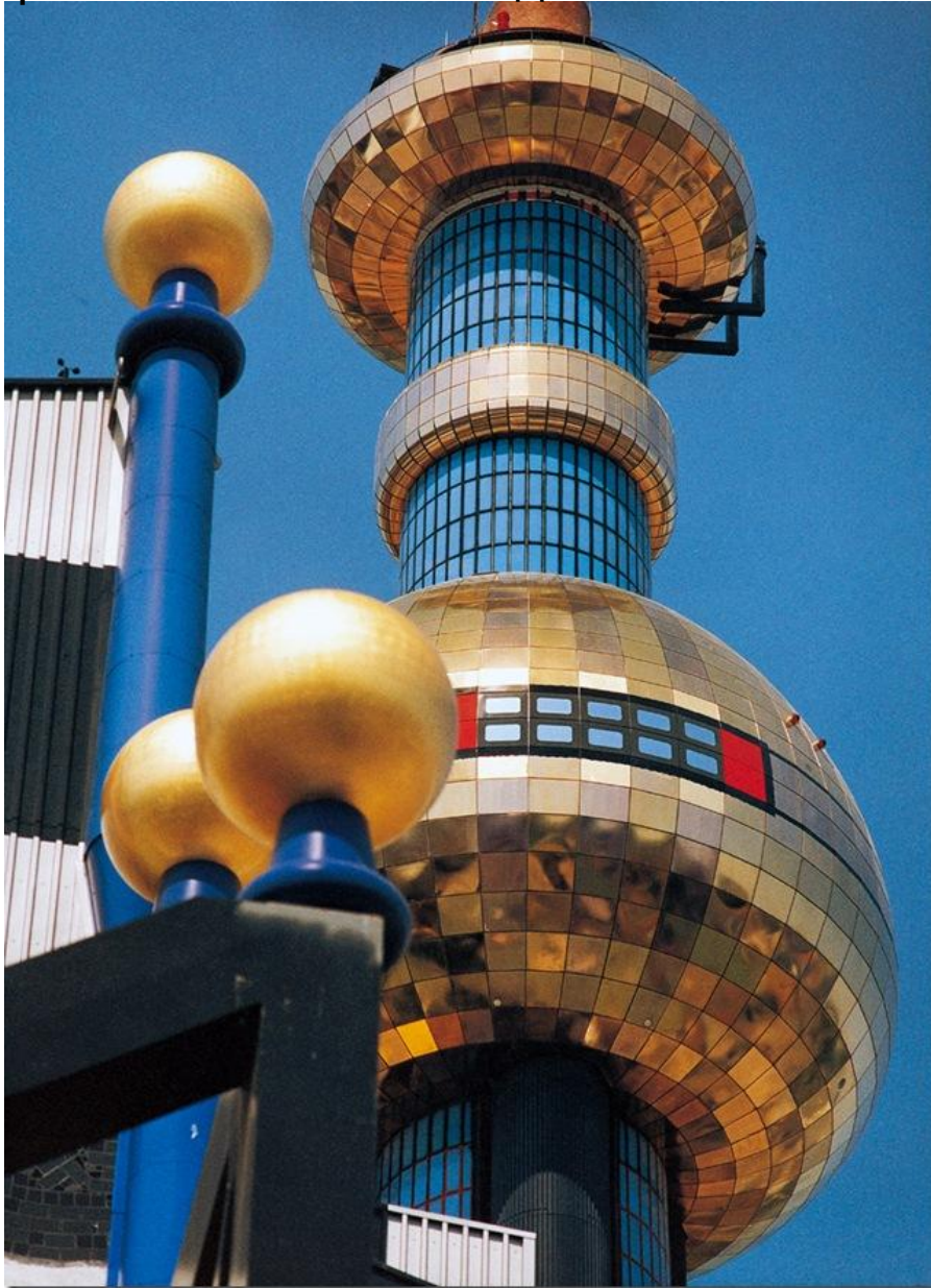
Мусоросжигательный завод в Вене 1988-1992
