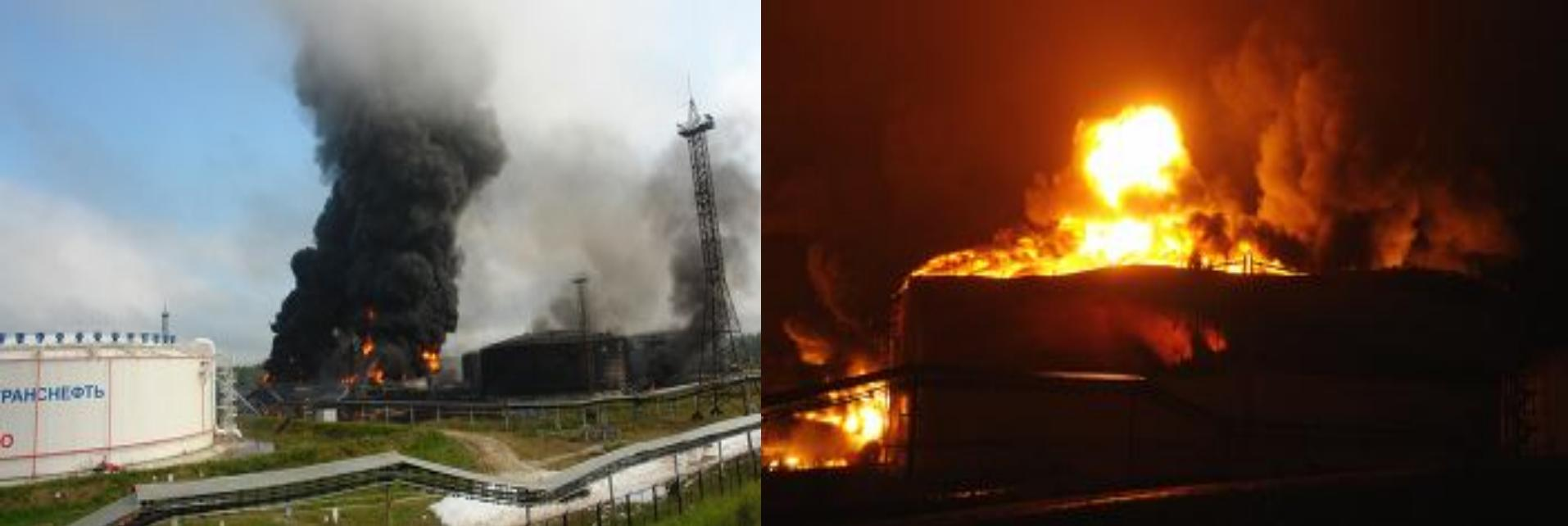
22 серпня 2009 р. на перекачувальній нафтовій станції Канда в Ханти-Мансійському АО загорівся резервуар з сирою нафтою обємом 20 тис. м<sup>3</sup> внаслідок прямого удару блискавки. Полумя перекинулось на 4 сусідні резервуари з нафтою. Внаслідок пожежі повністю зруйновано 3 резервуари, було проведено 3 пінні атаки для гасіння 2 сусідніх палаючих резервуарів, загальна площа пожежі склала більше 3 000 м<sup>2</sup>.
