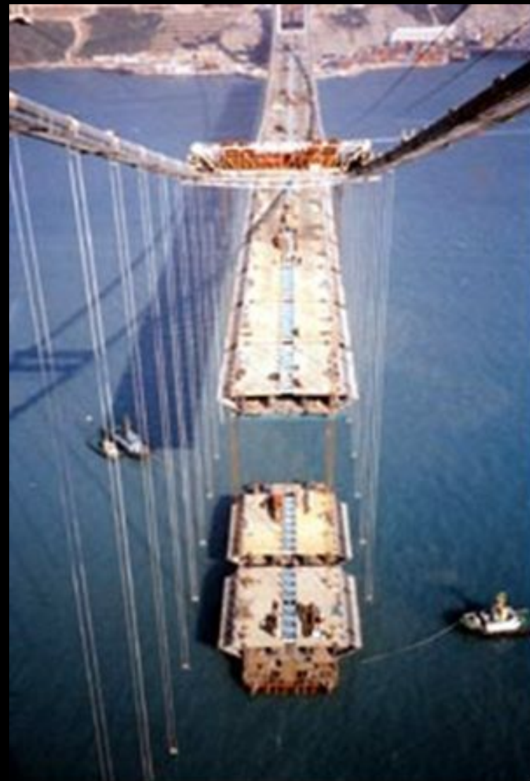
Рисунок 2.7. Монтаж модулей подвесного полотна.
