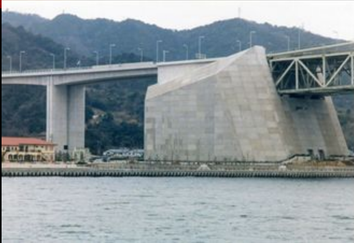
Рисунок 2.14. Анкерный устой моста (слева). Закрепление главного кабеля
