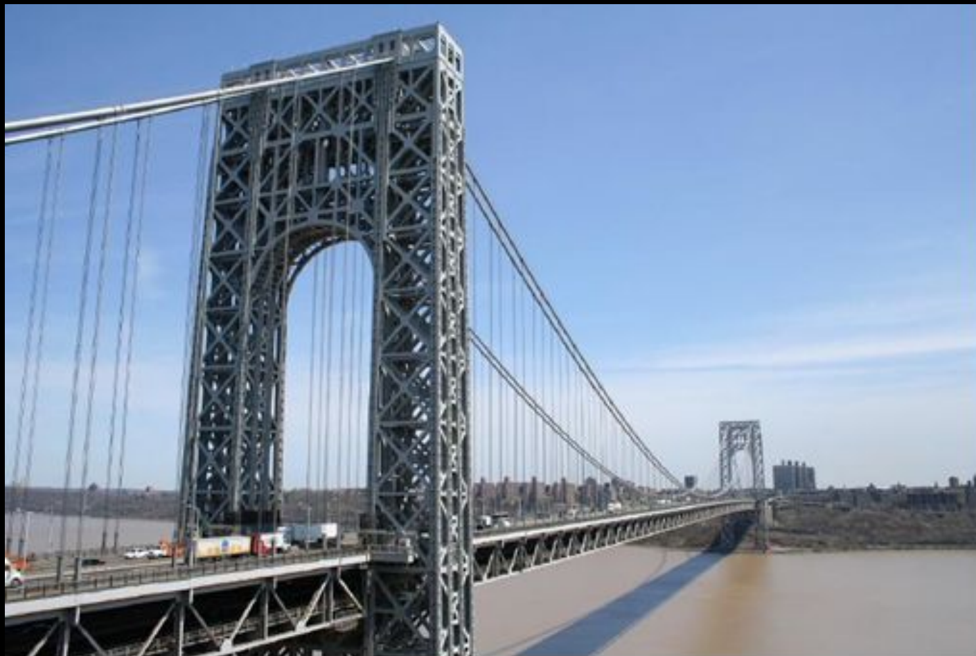
Рисунок 1.2. Мост Г. Вашингтона через р. Гудзон в Нью-Йорке.
