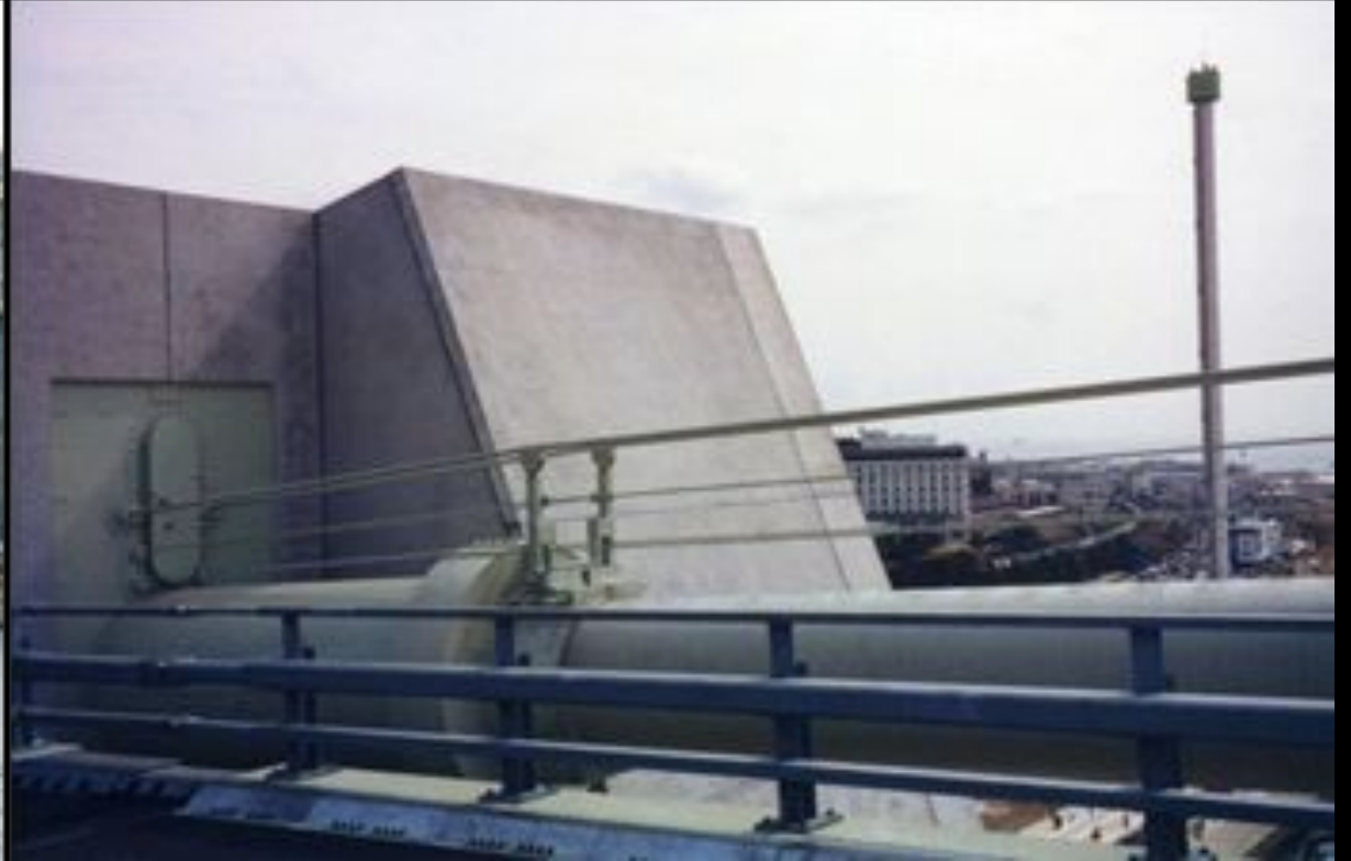
Рисунок 2.14. Анкерный устой моста (слева). Закрепление главного кабеля
