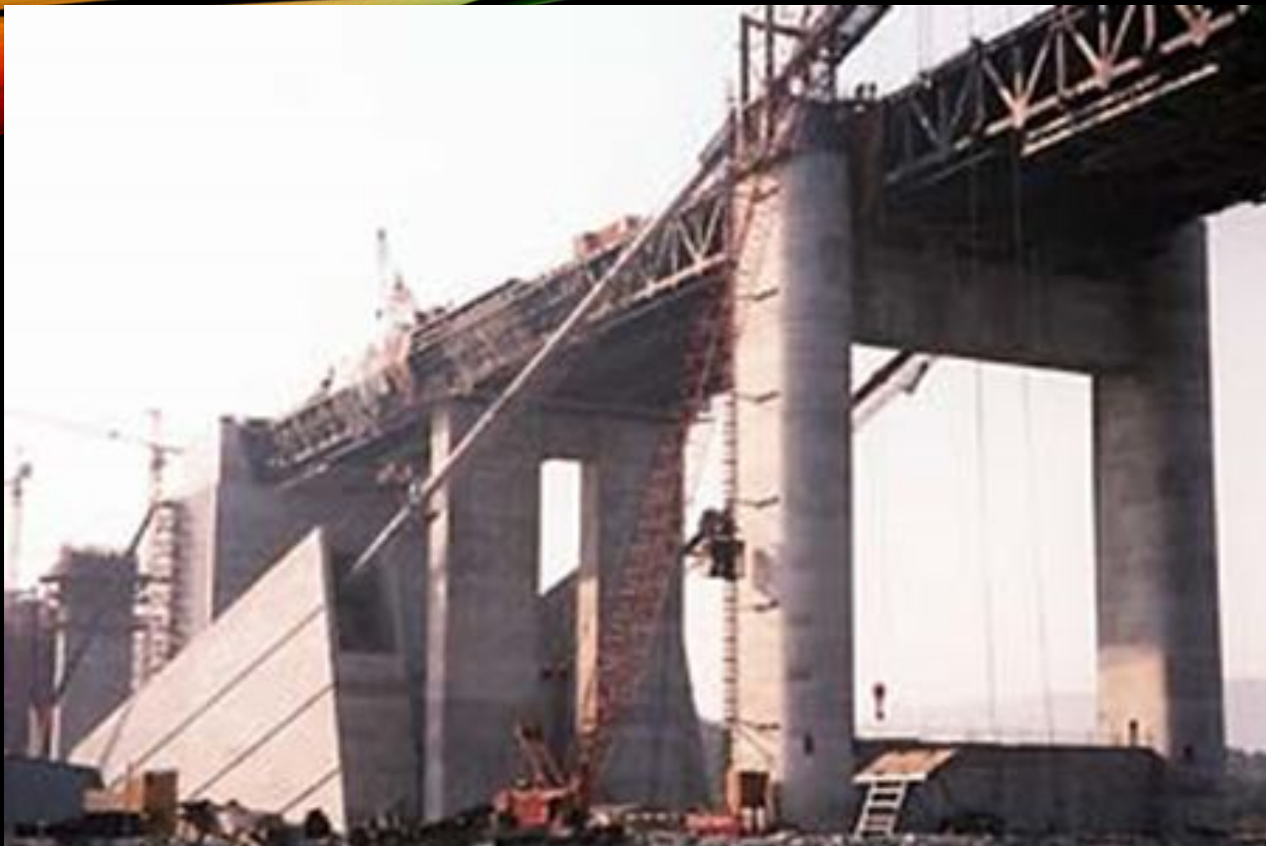
Рис. 2.5. Закрепление тросов в массивные бетонные блоки.
