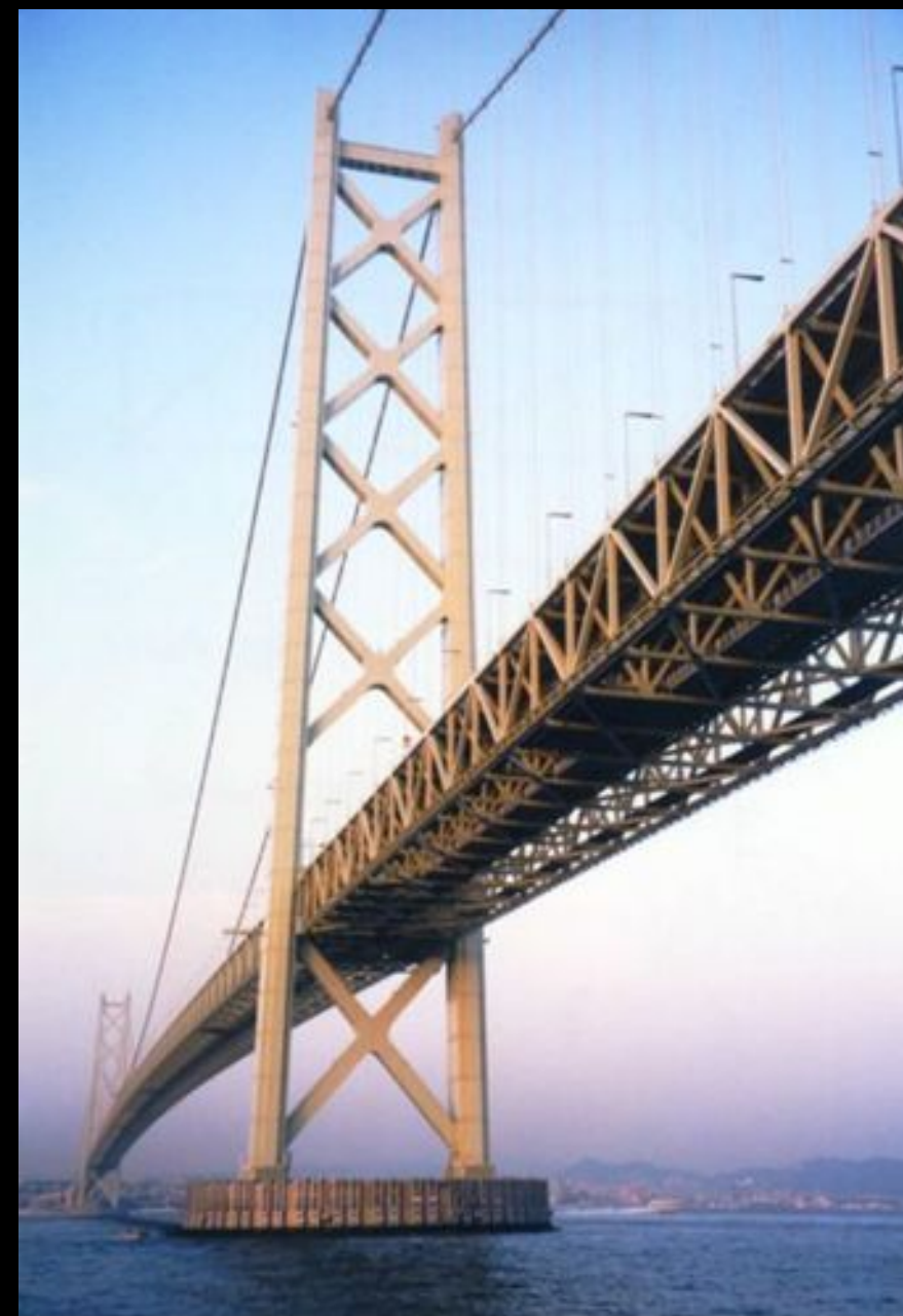
Рисунок 2.13. Вид опоры моста.
