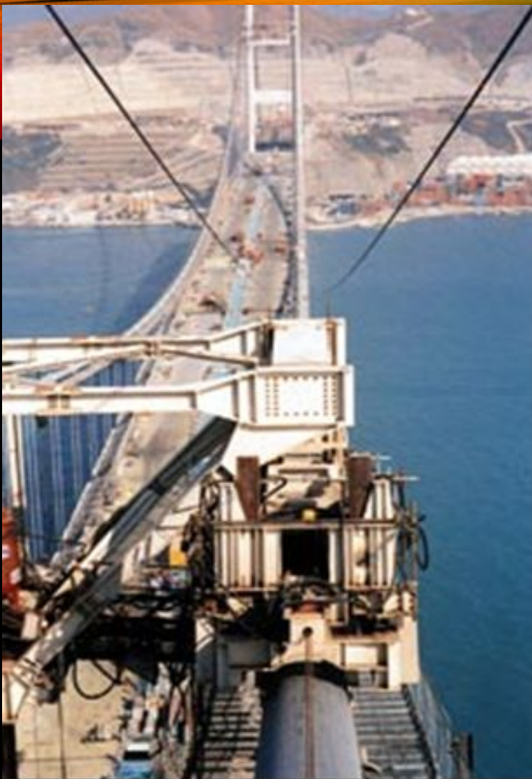
Рисунок 2.6. Изготовление тросов подвесным методом.
