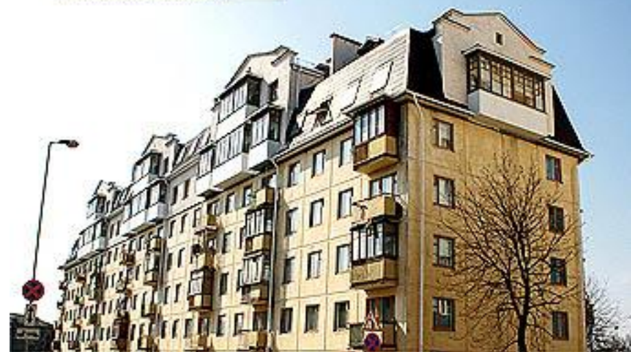
в процессе реконструкции Площадь нового жилья в мансарде - 1277 м 2
