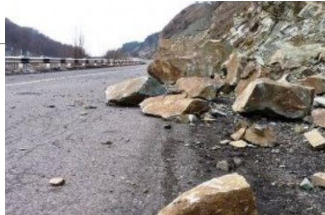
Осыпь, обвал, камнепад
