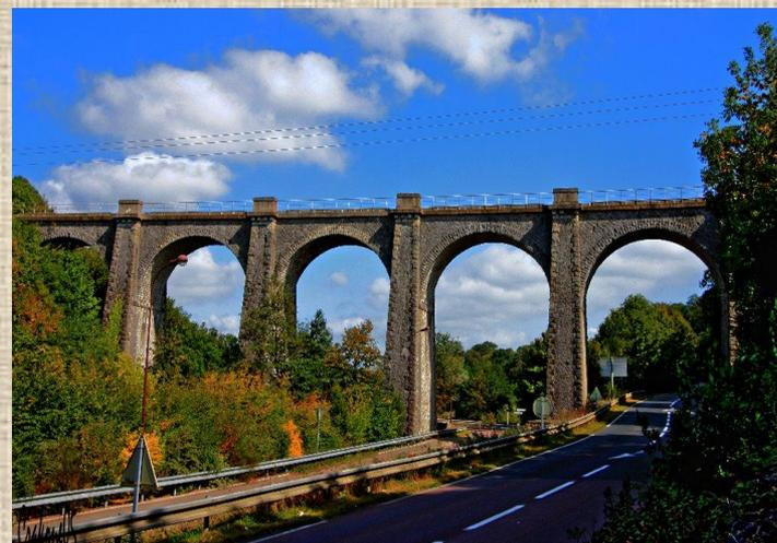
**Эстакады** - создают вместо больших насыпей в городах, где они меньше стесняют улицы и обеспечивают проезд и проход под ними, а также возводят на подходах к большим мостам через реки с широкими поймами при разливе воды.
