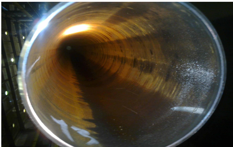
Зажированность поверхности
