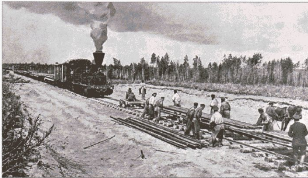
Строительство Транссибирской магистрали. Конец XIX в.
