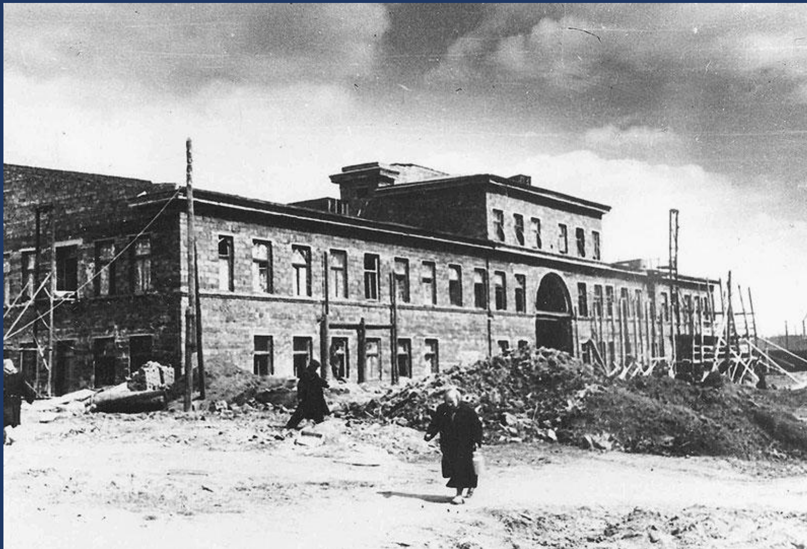
Строительство турбинного (турбомоторного) завода, 1938-1939гг.
