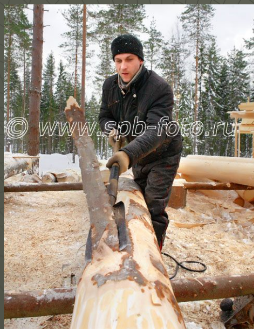
Окорка бревна вручную, при помощи окорочной лопаты
