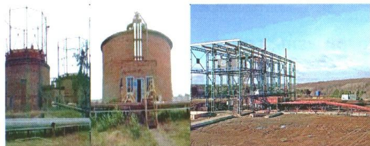
БИОЭНЕРГЕТИЧЕСКАЯ УСТАНОВКА НА РАЙОННЫХ ОЧИСТНЫХ СООРУЖЕНИЯХ ЗАО «ЧЕЛНЫВОДОКАНАЛ». Г. НАБЕРЕЖНЫЕ ЧЕЛНЫ, РТ
