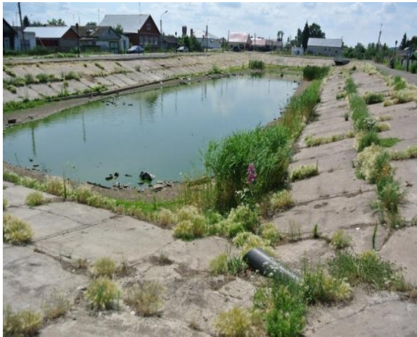
Общий вид водоема по ул. 8 Марта до реконструкции (лето 2015 года)
