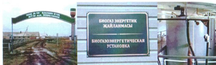
БИОГАЗОВАЯ УСТАНОВКА. БУИНСКИЙ РАЙОН, РТ
