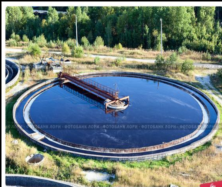
Радиальный отстойник на станции биологической очистки сточных вод © Кецяляйнен Андрей / Фотобанк Лори
