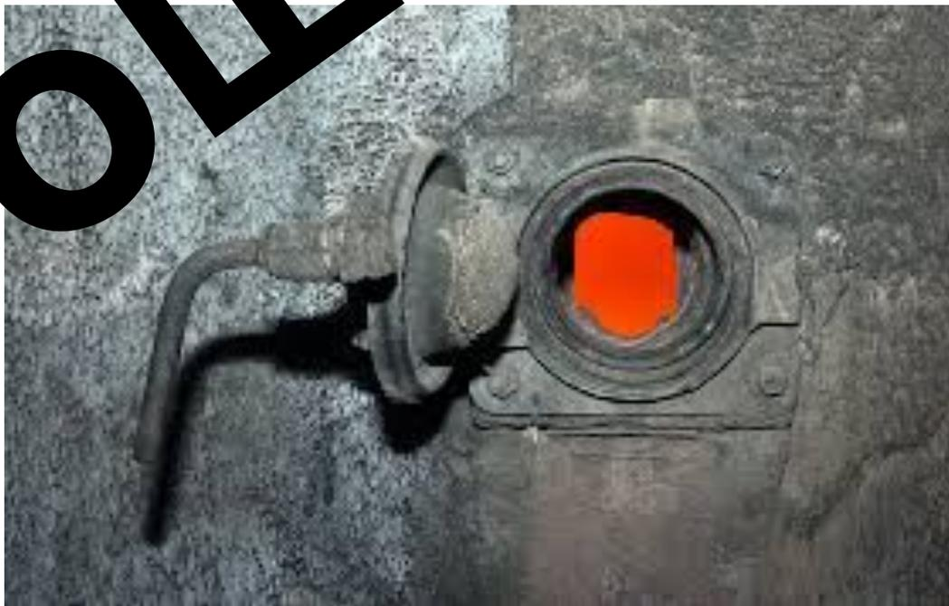
▣ **Взрывные клапаны** устанавливаются на боковых и потолочных стенах топки и газоходов с целью устранения или уменьшения разрушений обмуровки при хлопках и взрывах в топочной камере.
