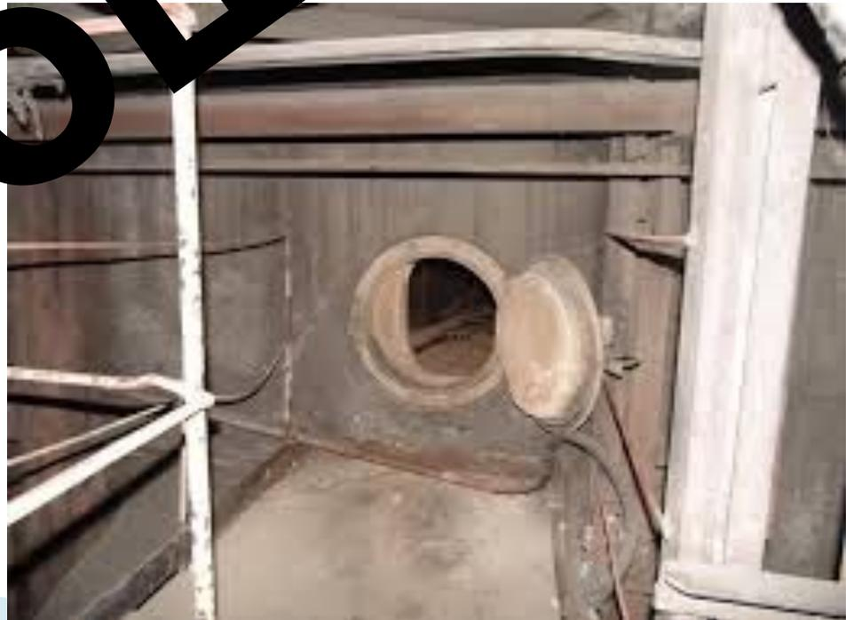
▣ **Лючки** предназначены для ввода в газоходы измерительной и диагностической аппаратуры, инструмента и приспособлений, используемых при ремонте и эксплуатации котельного агрегата.
