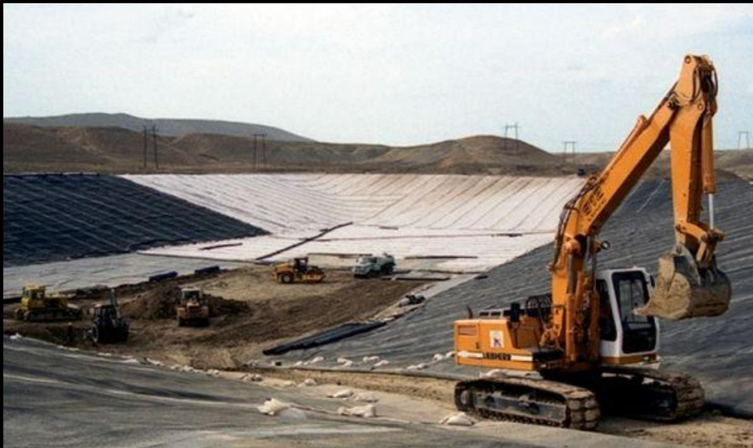
Практически на полигоне происходят процессы медленного биохимического (аэробного и анаэробного) разложения компонентов. Срок эксплуатации полигона обычно составляет 10-20 лет, а высота слоя отходов достигает 20-25 м. (в слое на глубине 3 м процесс разложения может длиться 15-20 лет, а в более глубоких слоях идет до 100 лет).
