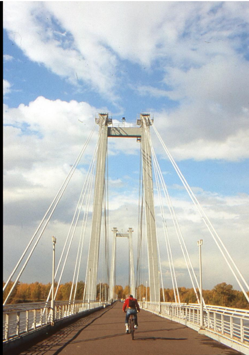
. г.Красноярск - Вантовый пешеходный мост (вид со стороны площади перед Большим Концертным залом, Триумфальной арки в сторону острова Татышева)
