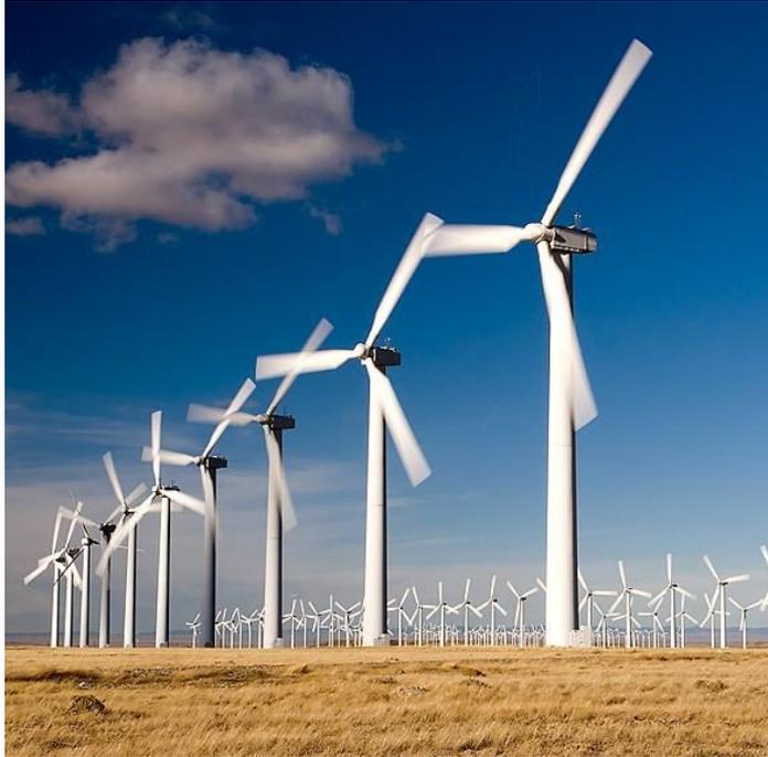
Главный элемент ветряной электростанции – ветрогенератор или ветряк. Это высокая мачта, на вершине которой установлена огромная трехлопастная ветротурбина, похожая на пропеллер. С помощью ветряка энергия движения воздушных масс преобразуется в электрическую, тепловую и другие виды энергий.
