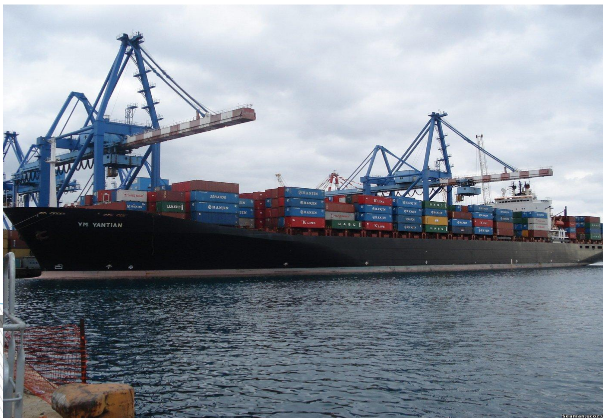
Причальный контейнерный перегружатель
