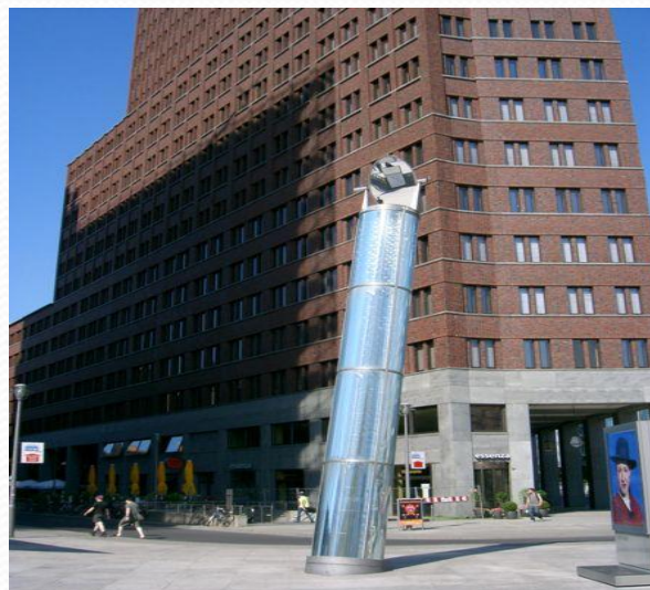
Световой колодец на станции метро в Берлине(верхняя часть)
