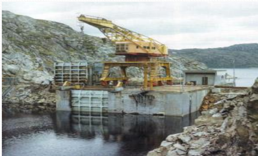
Кислогубская приливная электростанция
