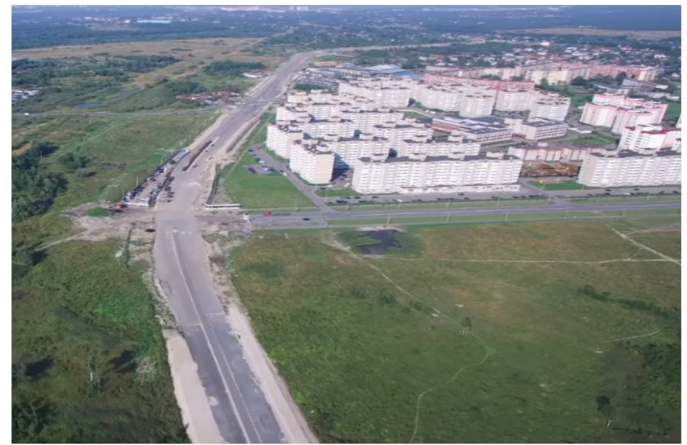
Строительство транспортного обхода города Красное Село
