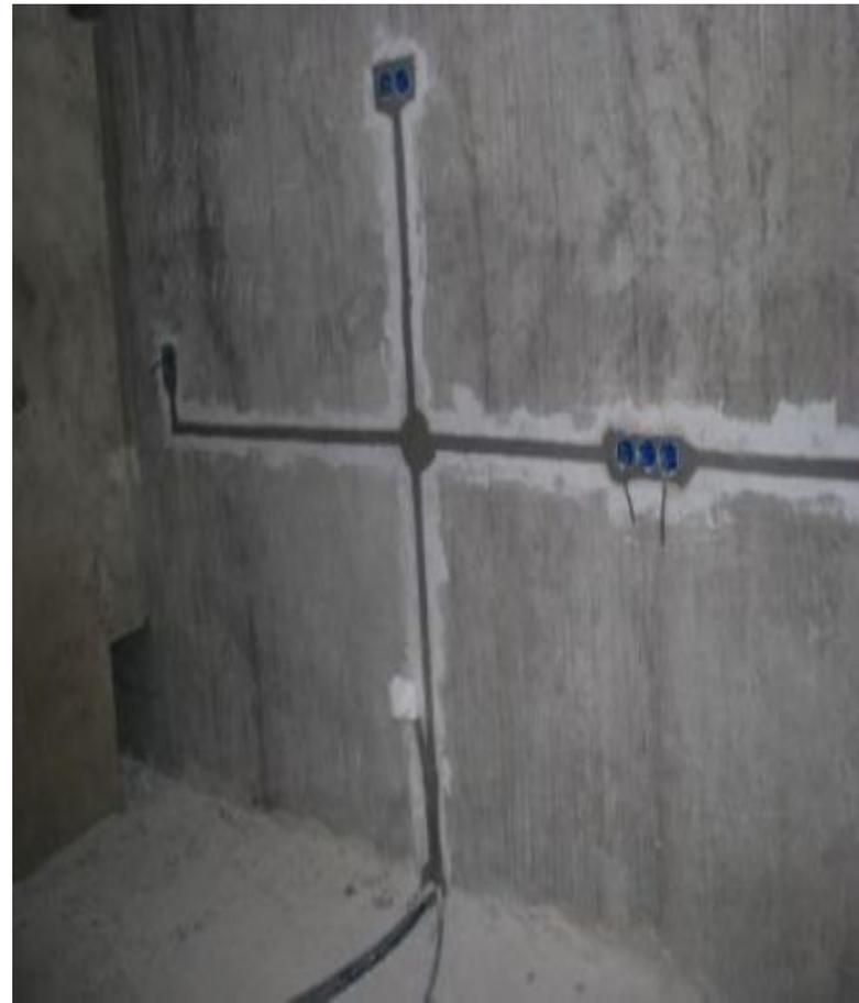
Монтаж электропроводок производят строго по проектной документации, в которой расписаны марки проводов и кабелей, места установки электрооборудования и светильников, пусковые и выключающие аппараты, места проходов через перекрытия или стены, трасса проводки и т.д.
