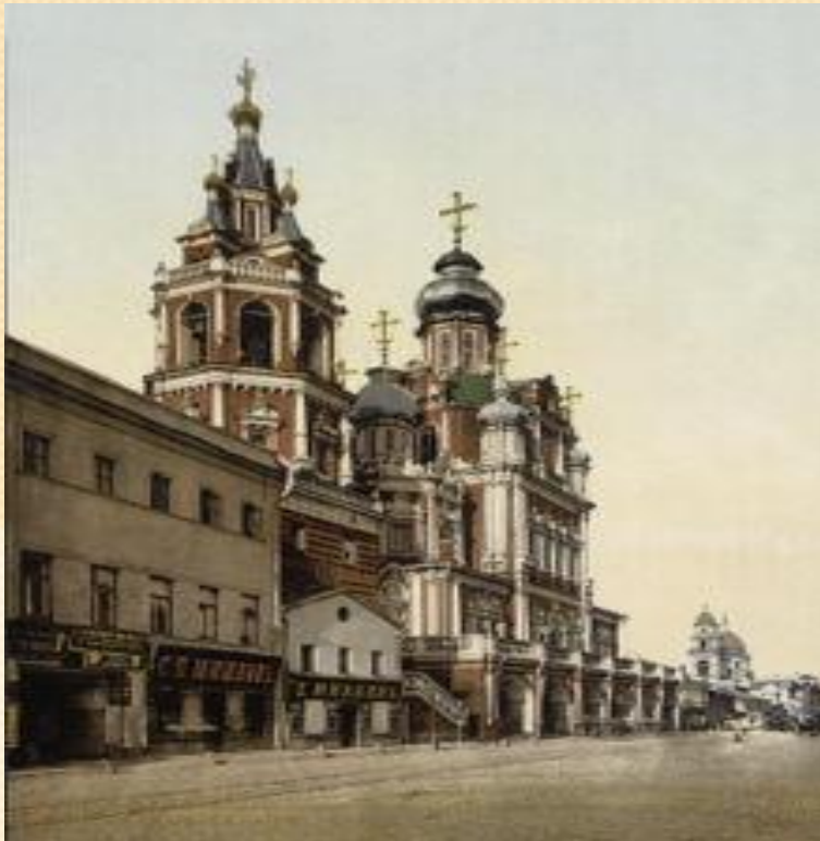
Церковь Успения на Покровке (1695 - 1699 гг.)
