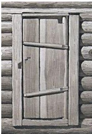
-Двухкосящитая дверь на пятах
