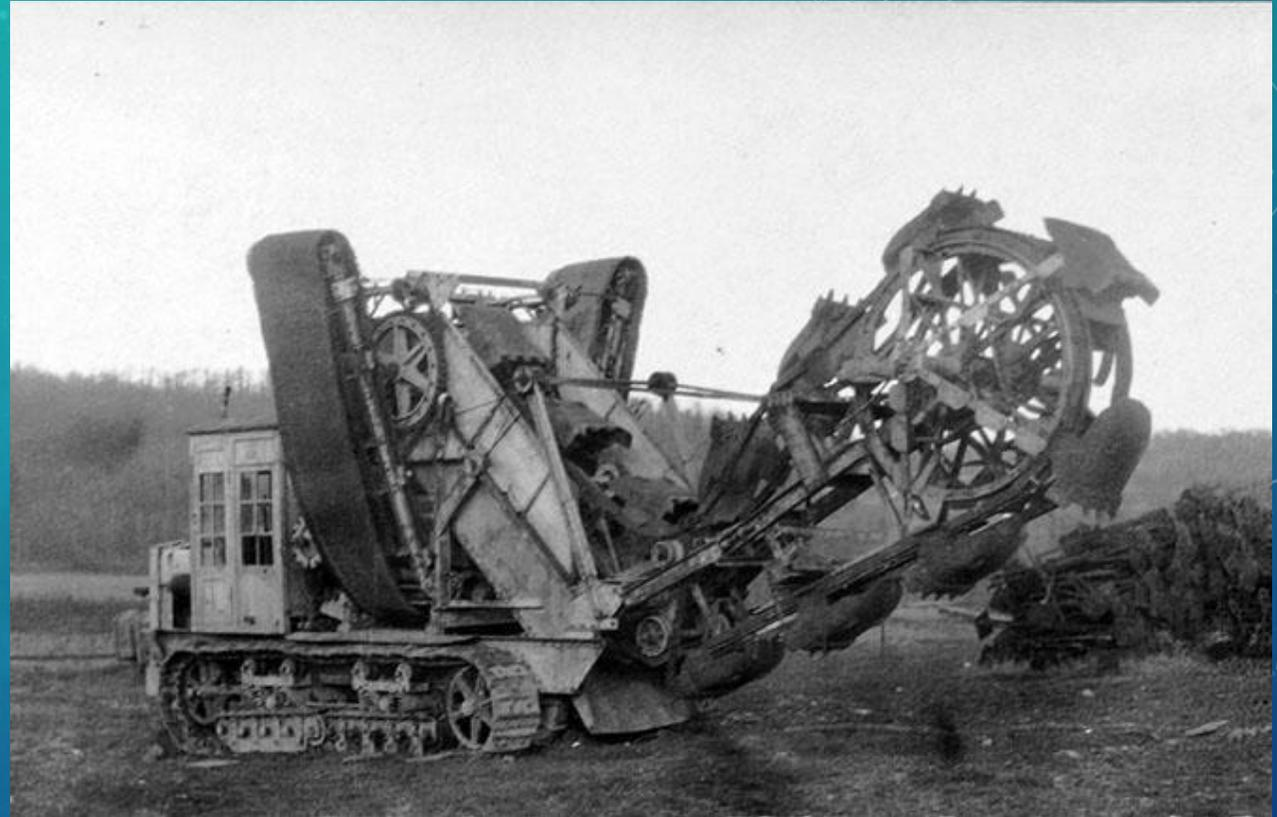
Немецкая машина для рытья окопов, 8 января 1918 года. Тысячи километров окопов были вырыты вручную, и лишь небольшая часть при помощи техники.
