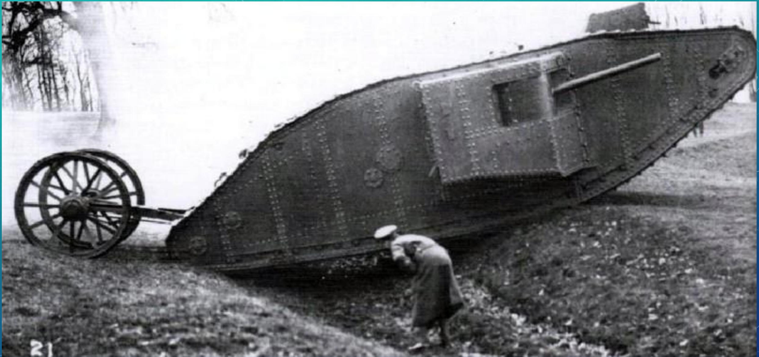
В период войны появились еще две модернизированные версии этого танка – МК 2 и МК 3. МК 2 отличалась от предшественника более широкой гусеничной лентой, а МК 3 от МК 2 усиленным бронированием. ( по 50 танков каждой модели)
