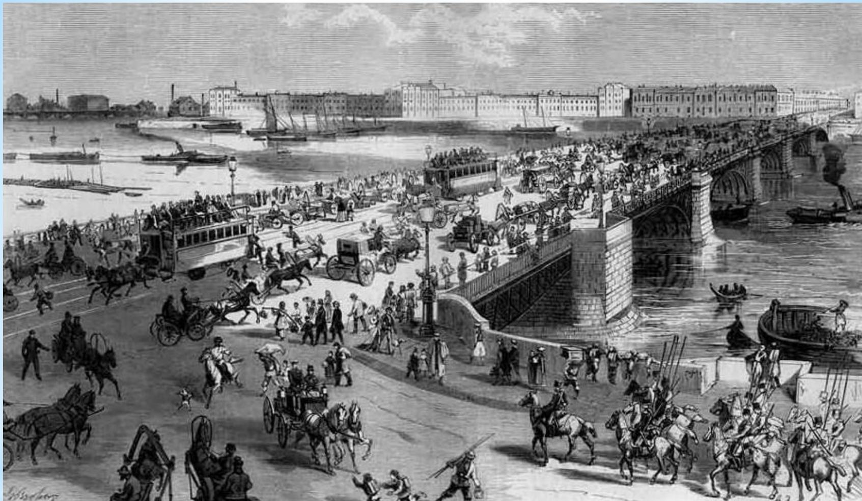
\* В 1875-1879 гг. построили постоянную переправу в виде пятипролетного металлического арочного моста с шестым поворотным пролетом по проекту А. Е. Струве.
