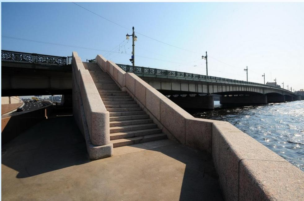
\* В 1966-1967 гг. - реконструирован. Заменены опоры, пролетные строения и разводной пролет заменен на вертикальный.
