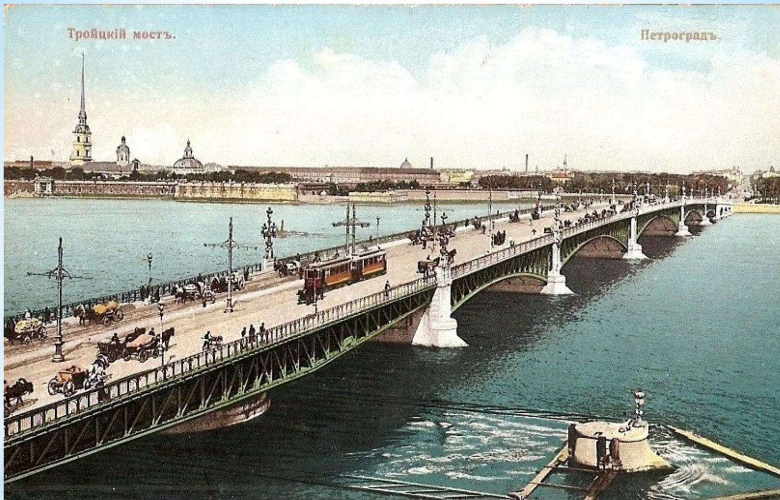
\* Левобережный разводной пролет был решен в виде двухконсольной уравновешенной фермы, вращающейся вокруг вертикальной оси, находящейся на первом от левого берега цилиндрическом быке.
