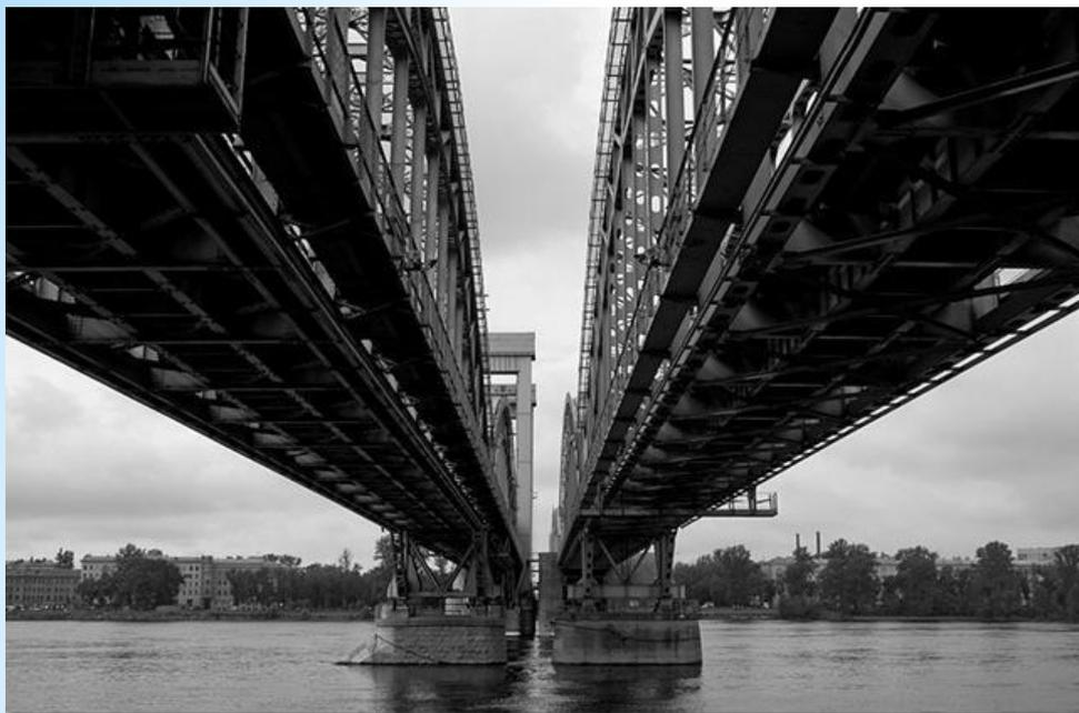
\* В 1983-1987 гг. параллельно старому мосту с низовой стороны был сооружен новый мост для движения поездов встречного направления. В 2002-2003 гг. мост подвергся реконструкции с заменой разводного пролета на вертикально-подъемный.
