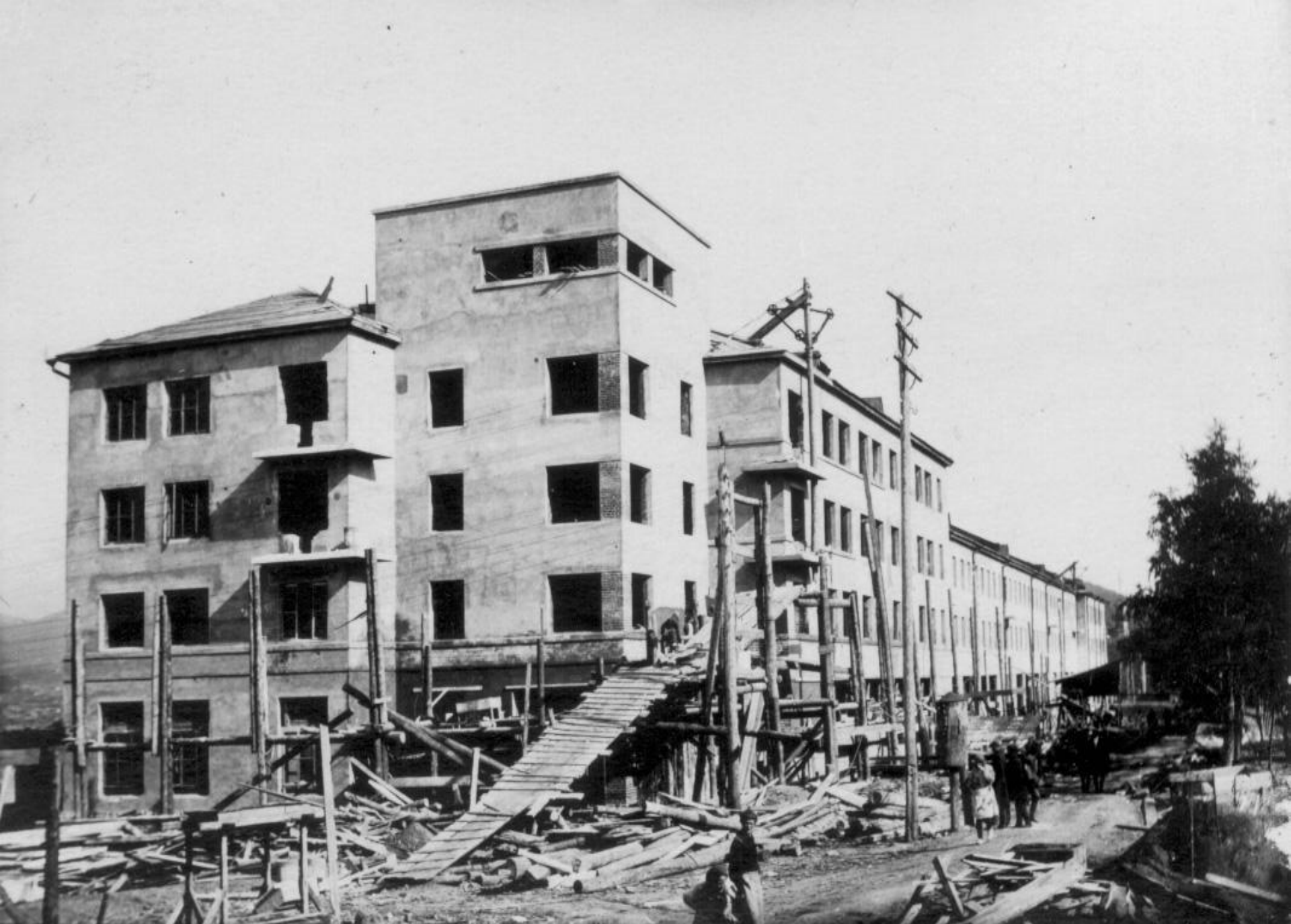
Строительство 48-и квартирного дома («48-и»)
