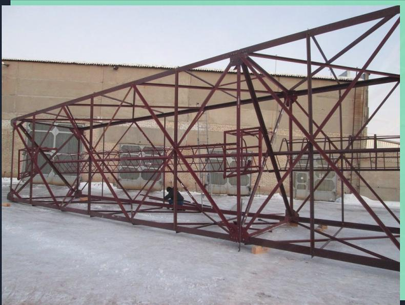
Современная практика строительства антенных сооружений основывается на преимущественном использовании металлов в качестве конструкционных материалов, поскольку это позволяет при сравнительно небольшой собственной массе обеспечить восприятие значительных нагрузок и относительно выполнение конструкциями технологических (радиотехнических) и строительных функций.
