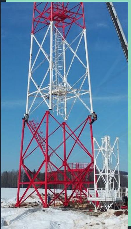
Антенно-мачочные сооружения могут быть изготовлены из угловой или из круглой прокатной стали. Назначение и предполагаемая нагрузка на АМС определяют выбор материала для их производства. Разные конструктивные элементы могут быть изготовлены из разного металла, однако их химические и механические характеристики не должны сильно различаться.
