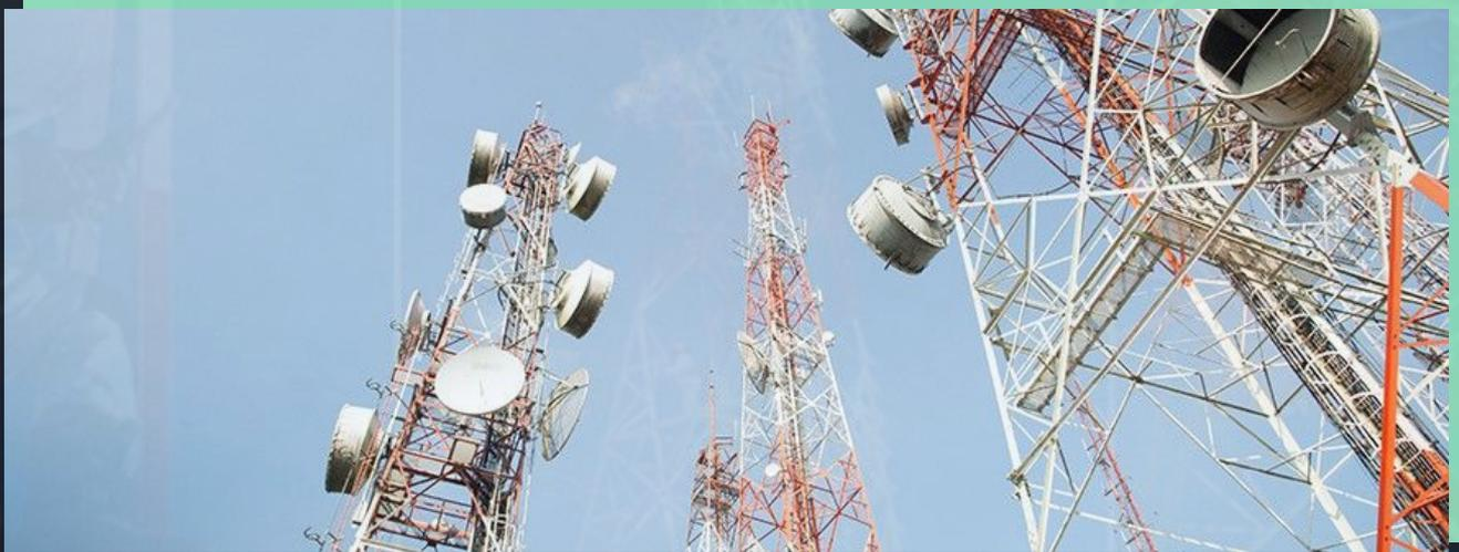
(АМС) — общее название для антенной опоры, входящей в состав оборудования площадки размещения радиоэлектронных средств (РЭС) связи.
