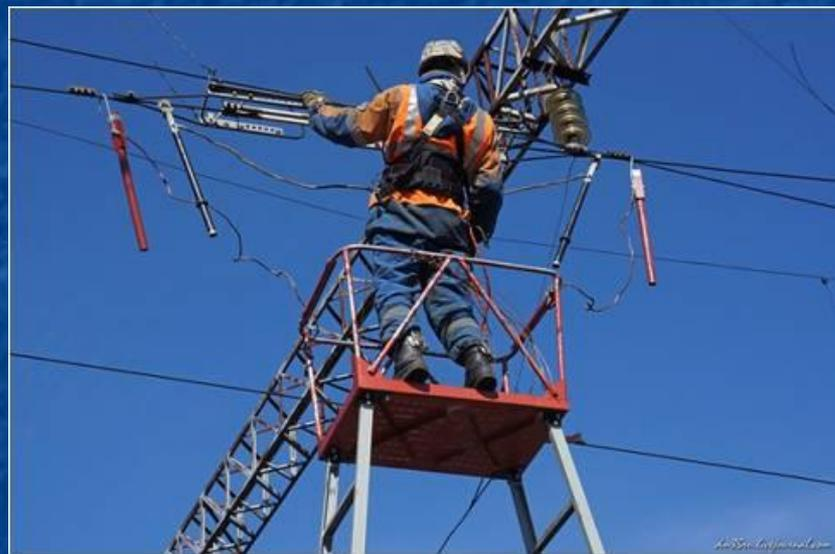
После окончания монтажа изоляторов повторноотрегулируем цепную подвеску по высоте в прилегающих пролетах и на воздушных стрелках.
