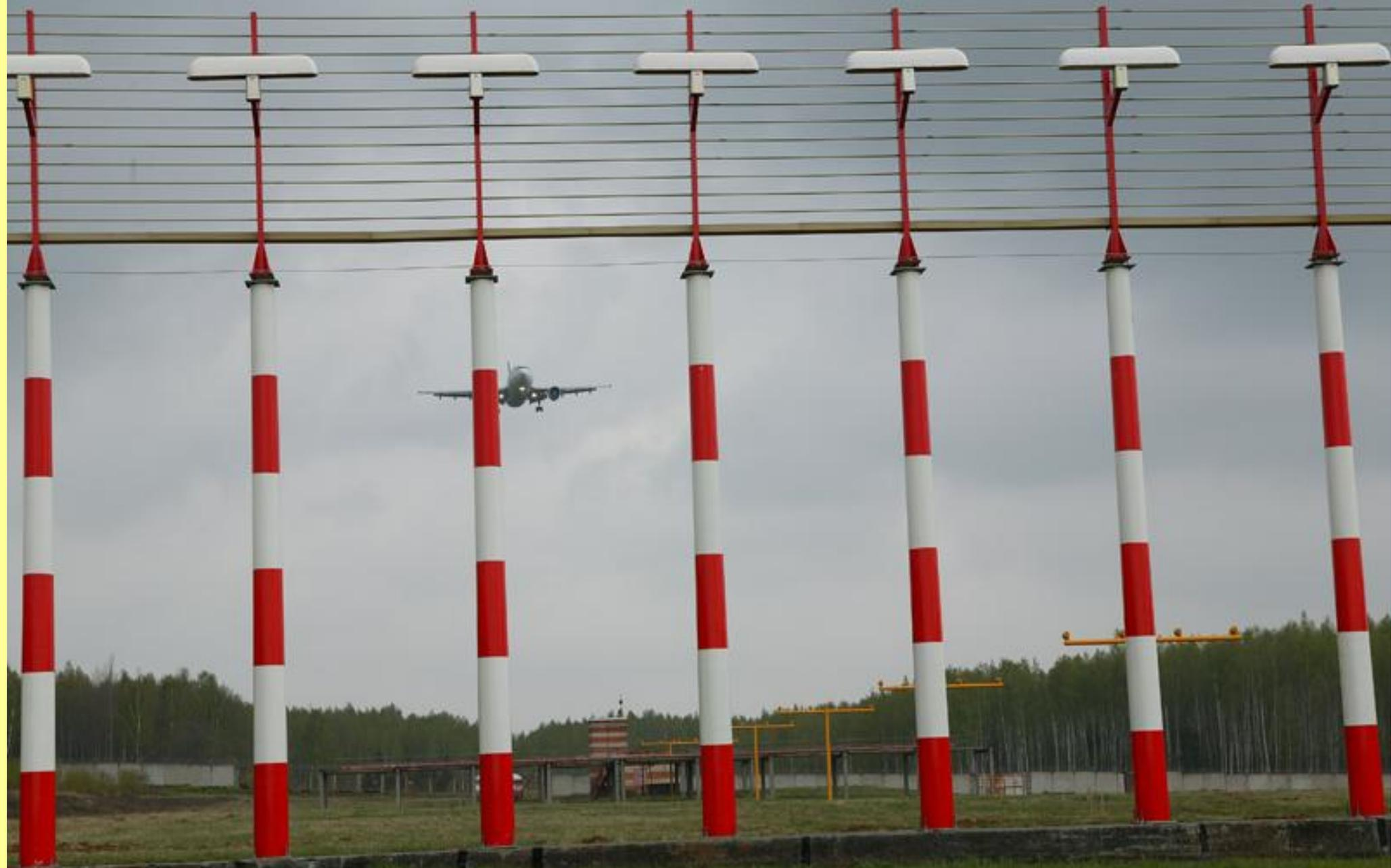
Глиссадный радиомаяк (ГРМ) формирует излучение на частоте 329 ... 335 МГц, позволяющее бортовому навигационному оборудованию самолета выбрать траекторию подлета в вертикальной плоскости – так называемую глиссаду.
