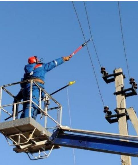
Для проверки возможности безопасного производства работ, правильности и качества установленных заземлений, отсутствия разрыва провода по трассе ВЛ необходимо проводить измерение наведенного напряжения при подготовке рабочего места.
