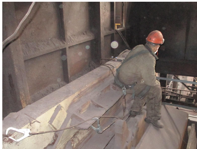
Строп пристегнут к боковой точке крепления на страховочной привязи
