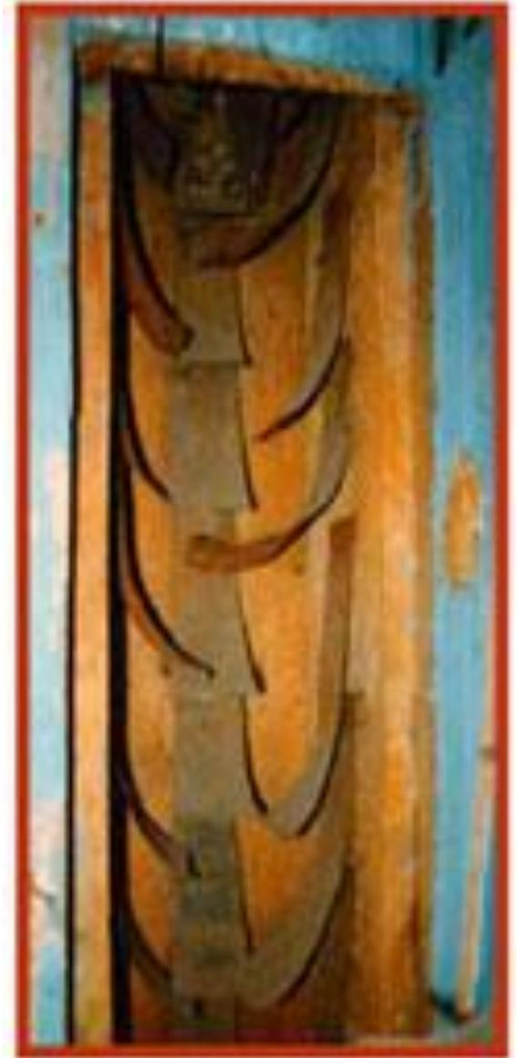
В деревянном колодце, находившемся в стене, в шахматном порядке были укреплены металлические лопасти, а сыпавшаяся на них сверху дробь создавала иллюзию шума дождя
