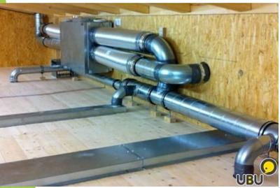
**Общеобменная вентиляция** предназначена для обеспечения воздухообмена во всем помещении или в его значительной части. Общеобменные *вытяжные* системы равномерно удаляют воздух из всего помещения, а *приточные* системы подают чистый воздух, распределяя его по всей площади.
