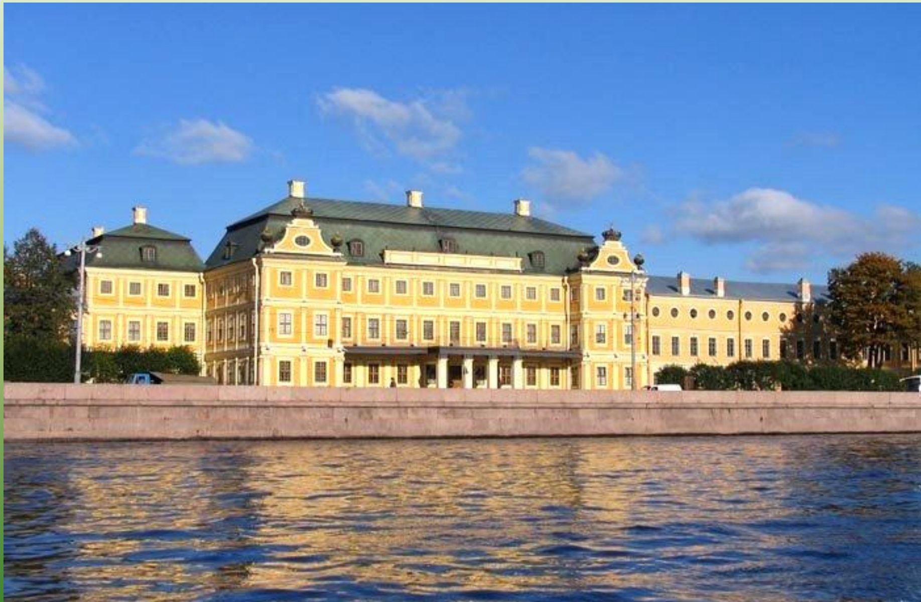
Дворец Меншикова Строительство 1710-1720 гг.
