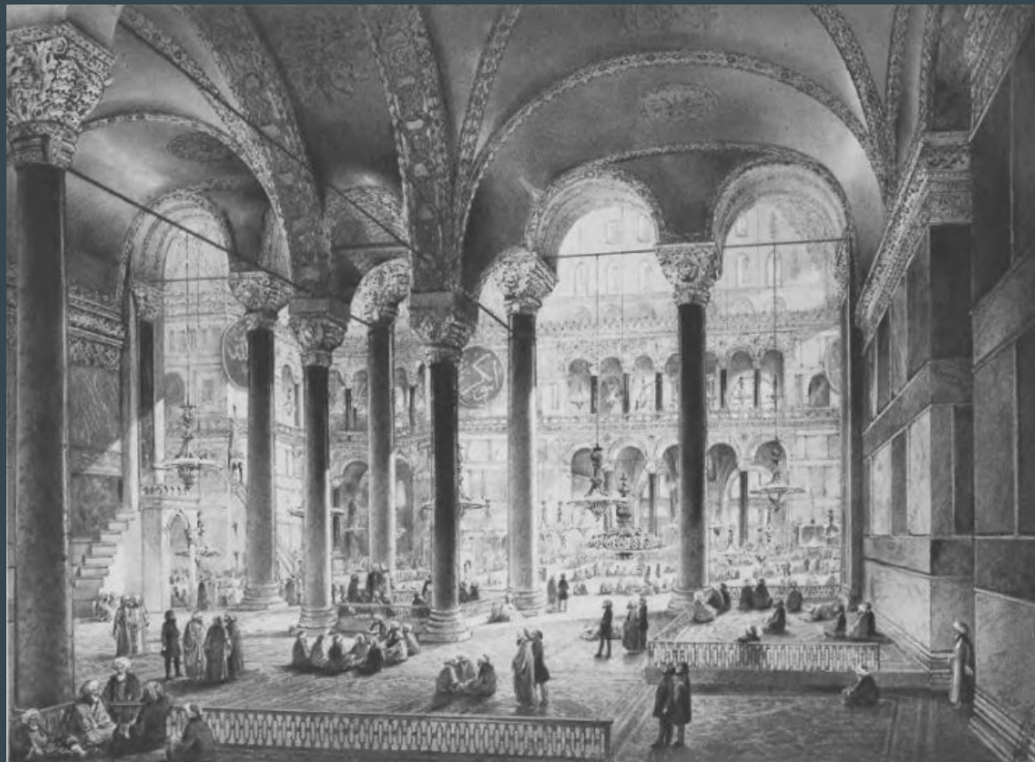
Центральный вид северного нефа в 1852 году. С картины Гаспаре Фоссати
