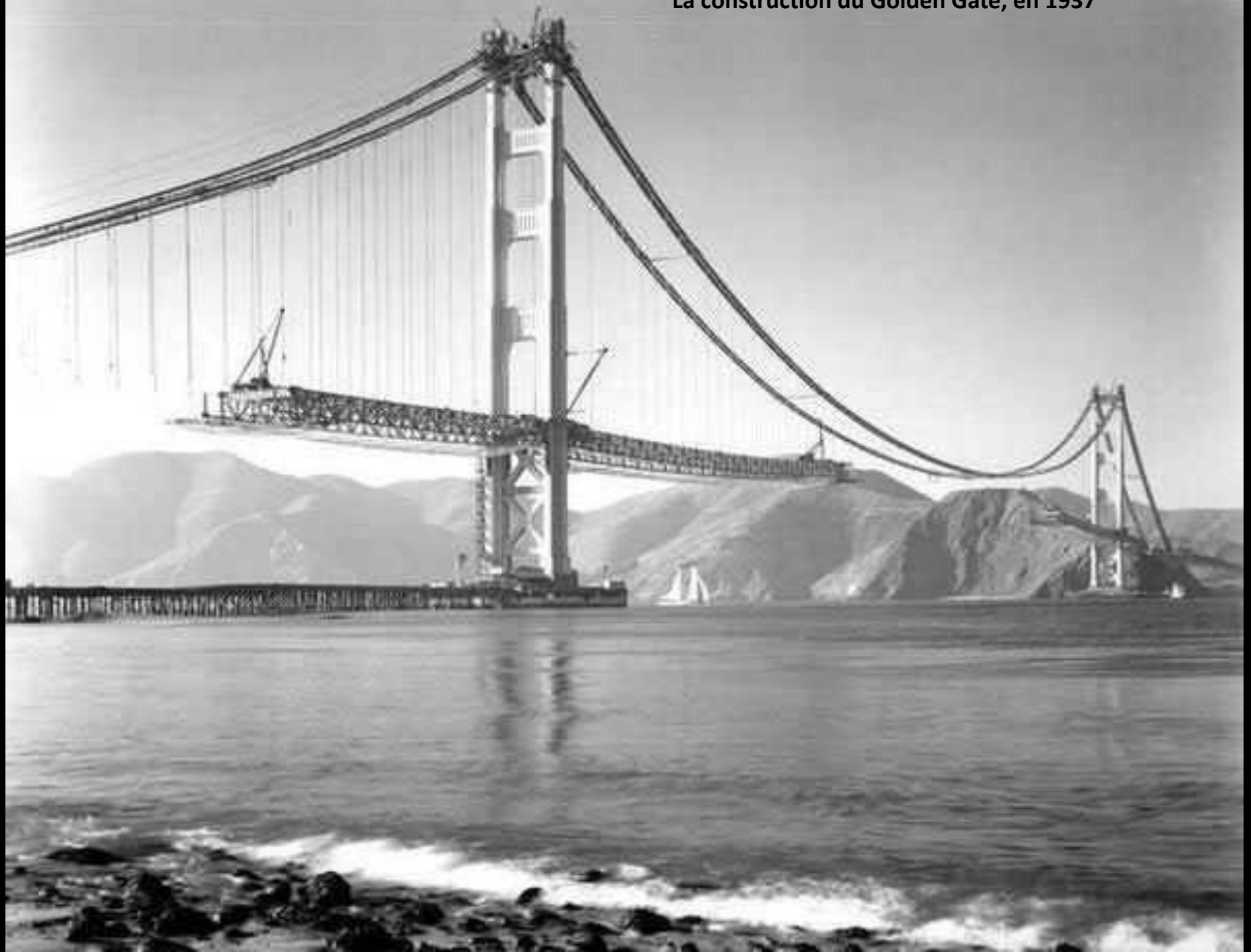
La construction du Golden Gate, en 1937
